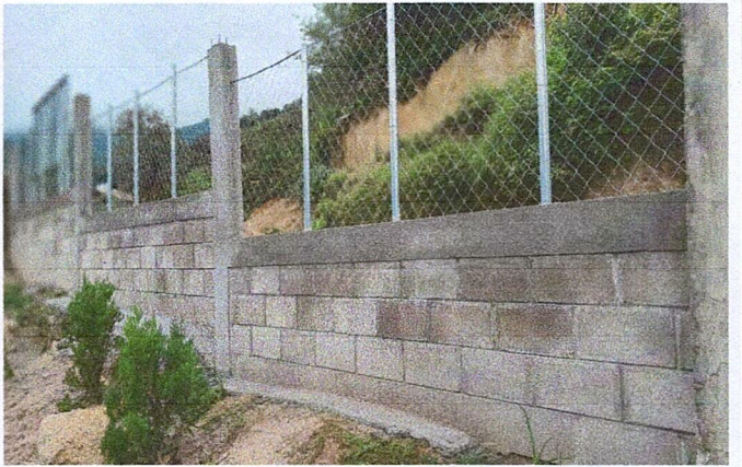
Foto 4: FINALIZACIÓN DE CERCO PERIMETRAL
